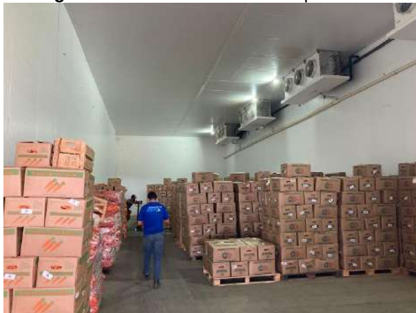
Figura 03: Câmara fria utilizada pela BAC.
