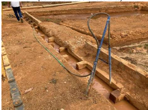
Figura 24: Sistema de recirculação de água proveniente dos sistemas de beneficiamento de hortifruti da BAC, da Paizão e da ULIMINAS (ponto em que é adicionado o floculante).
