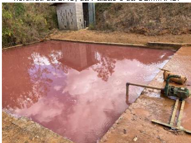
Figura 28: Sistema de recirculação de água proveniente dos sistemas de beneficiamento de hortifruti da BAC, da Paizão e da ULMINAS.
