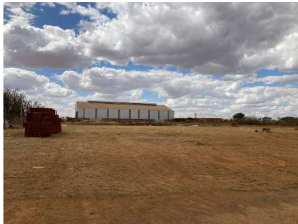
Figura 19: Área onde encontra-se enterrado o sistema de tratamento de efluentes sanitários.
