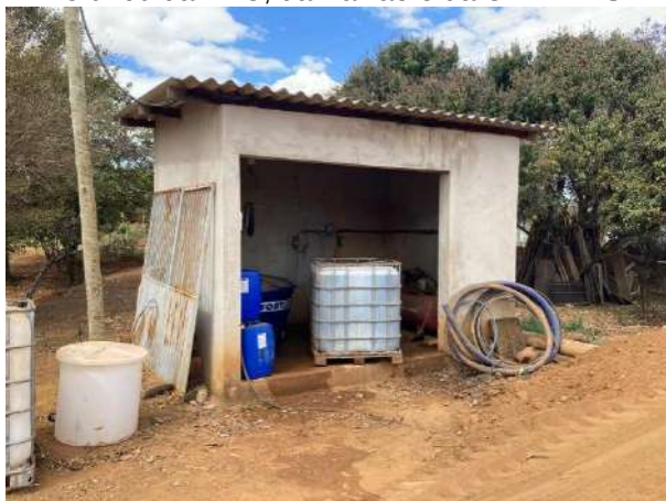
Figura 25: Ponto de armazenamento de produtos químicos usados na clarificação do efluente proveniente dos sistemas de beneficiamento de hortifruti da BAC, da Paizão e da ULIMINAS.
