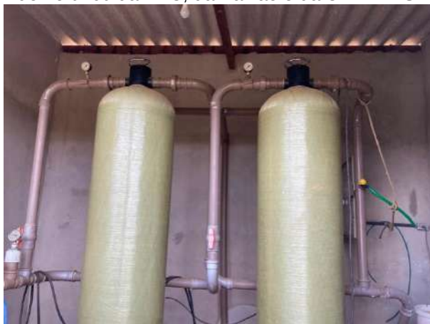
Figura 31: Filtros do sistema de recirculação de água proveniente dos sistemas de beneficiamento de hortifruti da BAC, da Paizão e da ULMINAS.
