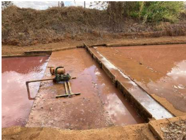
Figura 27: Sistema de recirculação de água proveniente dos sistemas de beneficiamento de hortifruti da BAC, da Paizão e da ULMINAS.
