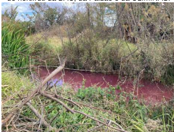
Figura 29: Canal do sistema de recirculação de água proveniente dos sistemas de beneficiamento de hortifruti da BAC, da Paizão e da ULMINAS.
