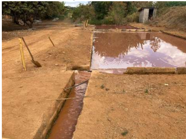
Figura 26: Sistema de recirculação de água proveniente dos sistemas de beneficiamento de hortifruti da BAC, da Paizão e da ULMINAS.
